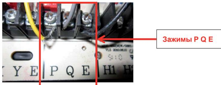
\*Внутренние блоки должны быть подключены к единому источнику электропитания; в противном случае возможно возникновение гидроудара в компрессоре.
